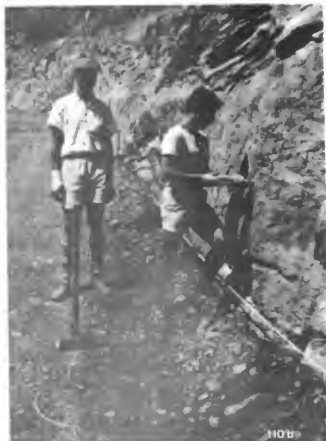
MESURE AU SCLEROMETRE SCHMIDT DE 5 OU 6 POINTS DE LA SURFACE
